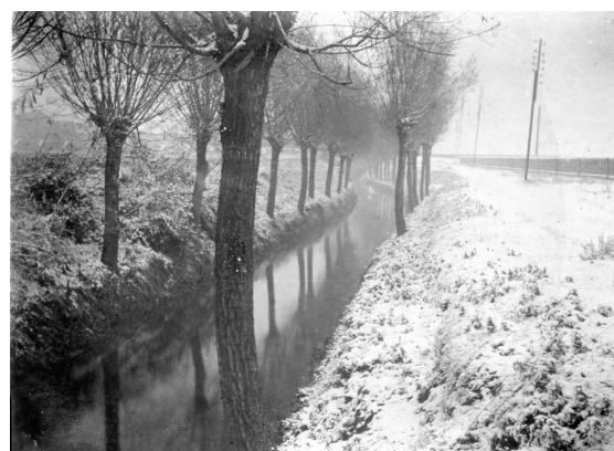
Imatges 35 i 36. Rec comtal a l'alçada de La Sagrera. Arxiu fotogràfic del Centre de Documentació de La Sagrera
