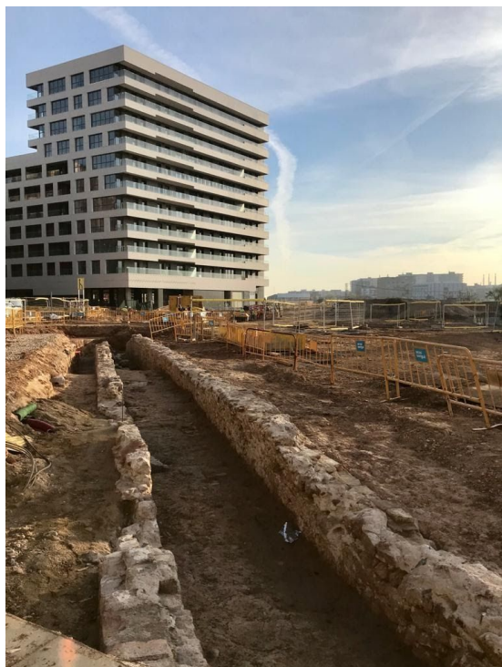
Imatge 22. Mur estructural del Rec Comtal a l'entrecruament de Carrer Gran amb Ciutat d'Eix. 2020.
