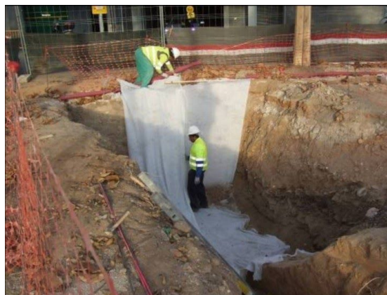
Imatge 18 i 19. Cobertura de les estructures a la rasa 100. Fotografia núm. 28 i 27. González, Lluís Juan. 2015.
