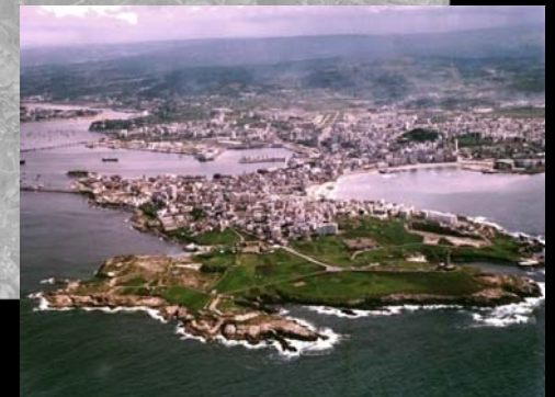
Vista zona Torre 1972
