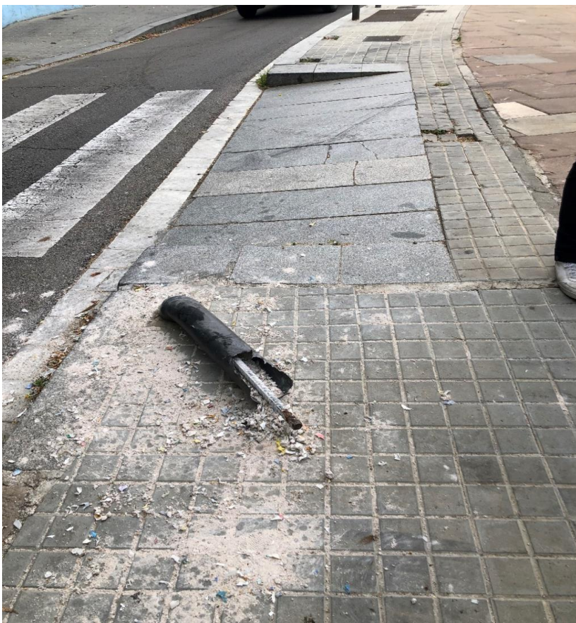
Carrer de Natzaret, 44 amb Escola M. de Déu de Montserrat (Foto 49)
